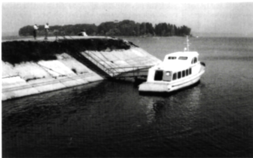
Necitlivé technické riešenie oplášťovania brehov (Oravská priehrada pri Slanickom ostrove)
