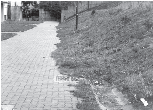
Vľavo pohľad na chodník pri detskom ihrisku. Zle zabezpečený svah s eróznymi zátekmi, ktoré zaplavujú chodník vydláždený mozaikovou dlažbou. Vpravo protierózne zabezpečený svah zdevastovaný detskými hrami. (Rekognoskácia: Ul. Jána Stanislava na sídlisku Dlhé diely v Karlovej Vsi.)
