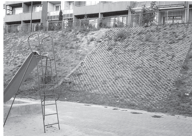
Vľavo pohľad na chodník pri detskom ihrisku. Zle zabezpečený svah s eróznymi zátekmi, ktoré zaplavujú chodník vydláždený mozaikovou dlažbou. Vpravo protierózne zabezpečený svah zdevastovaný detskými hrami. (Rekognoskácia: Ul. Jána Stanislava na sídlisku Dlhé diely v Karlovej Vsi.)
