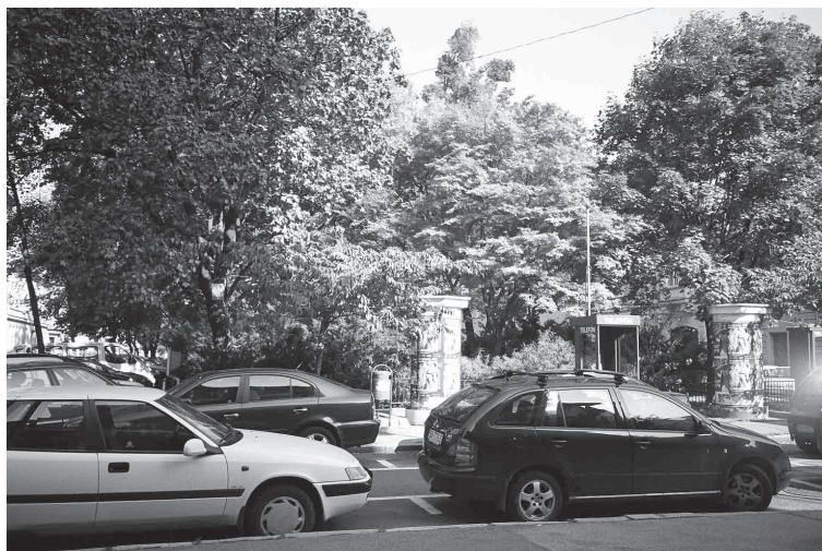
CHA Jakubovský parčík, ktorý sa nachádza v centre Starého Mesta, je neustále atakovaný negatívnymi vplyvmi. Jeho ďalšia existencia je ohrozená. Foto: I. Šimonides
