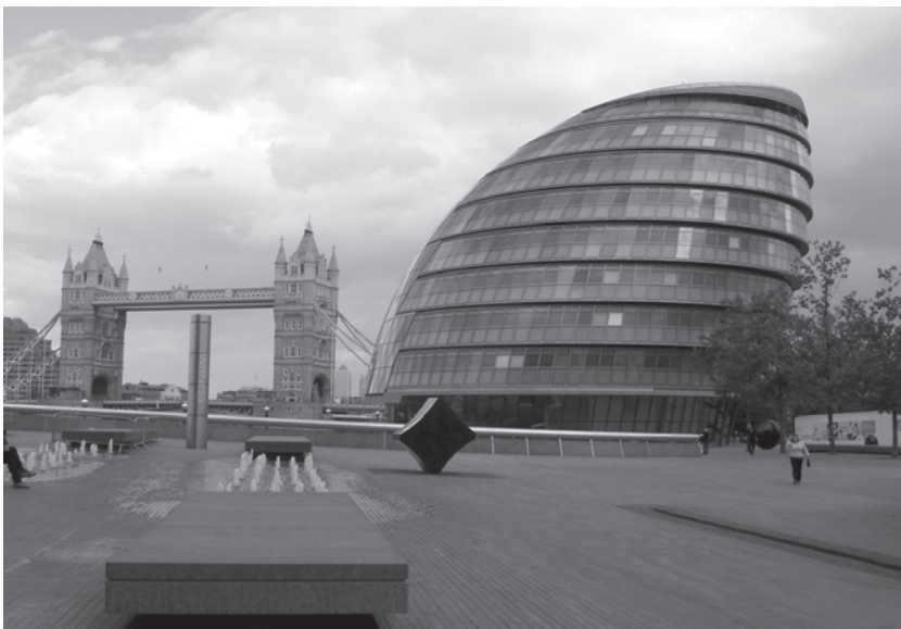
2. Londýnska radnica (Norman Foster a partneri, 2002) je navrhnutá ako ekologicky motivovaná stavba, ktorá zohľadňuje slnečné vplyvy, využíva princíp prirodzeného vetrania a pod. Realizácii predchádzali počítačové simulácie prevádzky budovy (vetrania, vykurovania, chladenia). Foto: J. Kepl
