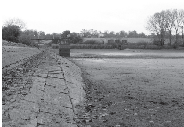
3. Vodná nádrž zanesená vplyvom eróznno-akumulačných procesov (Vráble). Foto: J. Lieskovský
