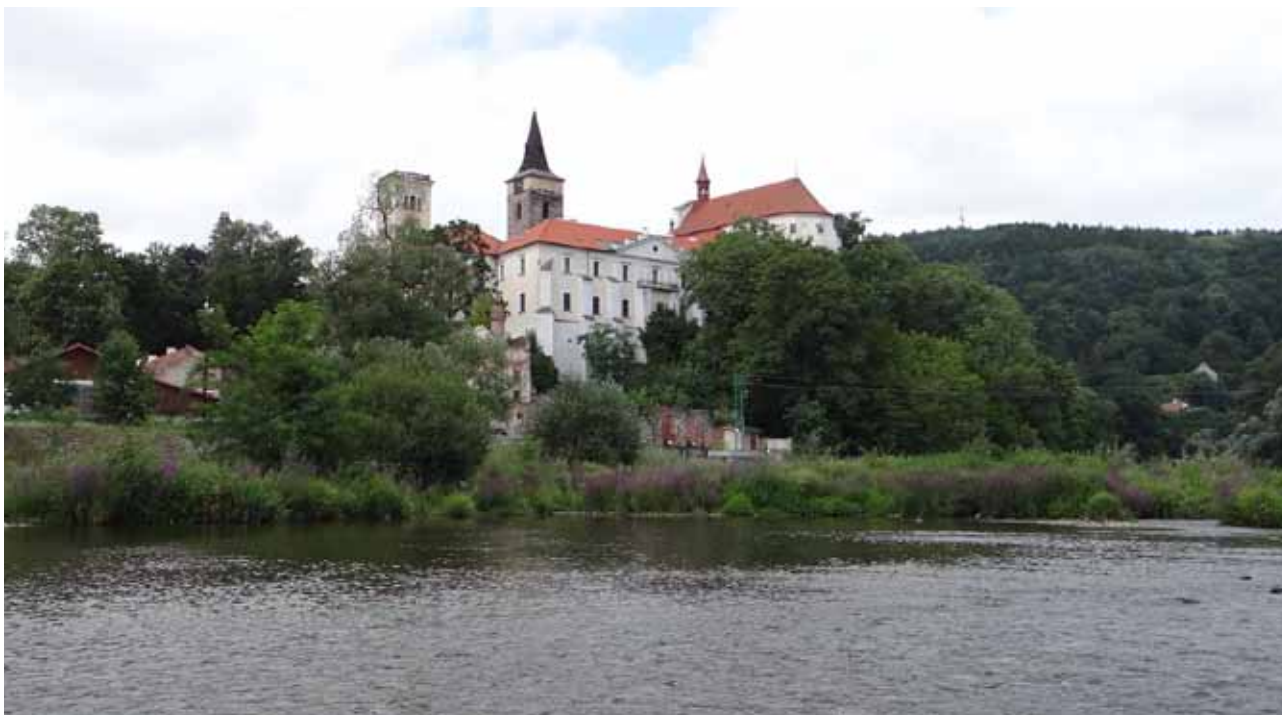
Obr. 1. Pohled na Sázavský klášter a bývalý hospodářský dvůr od řeky Sázavy (srpen 2017). Foto: Markéta Šantrůčková
